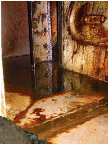
**Fettablagerungen und Versottungen** in Dunstabzugshaube, Lüftungsdecke, Abluftkanal und Abluftventilator.
